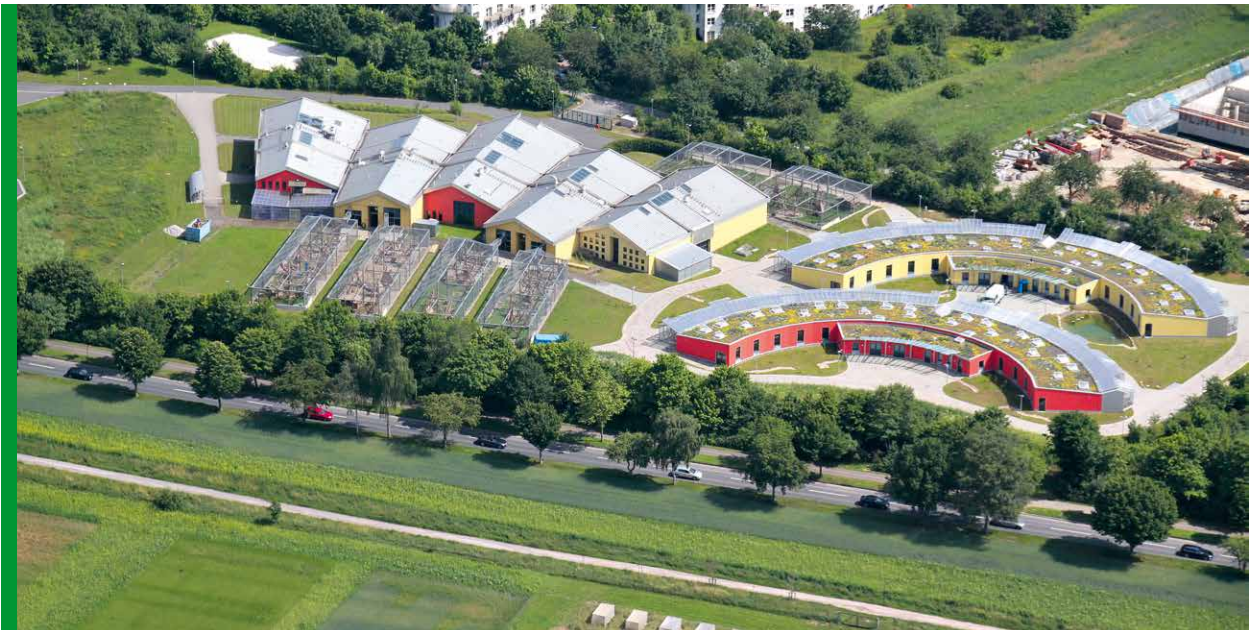
Anfang 2004 konnten die Primaten die neu gebauten Quartiere inklusive Außengehegen (links) beziehen. Die halbrunden Gebäude rechts daneben waren Anfang 2012 bezugsfertig und boten neue räumliche Ressourcen für die Primatenzucht des DPZ. ■ Early 2004, primates were moved to the newly built quarters at the DPZ (left). The semicircular buildings to the right were ready by 2012 and provided new breeding facilities for primates. Photo: Stefan Rampfel
